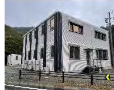
オフィス棟 外観
