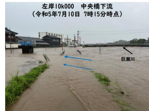
巨瀬川の氾濫状況
