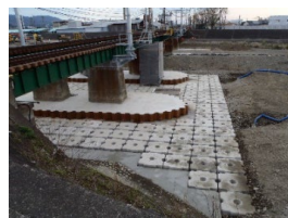
鉄道橋りょうの流失・傾斜対策
