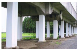
鋼板巻きによる高架橋の耐震補強
