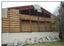
外壁の全面的な脱落事例
