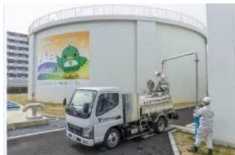
図2：応急給水設備から給水車に給水している様子
