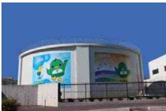
図1：耐震性能を有した配水池
