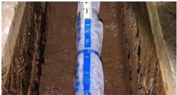
配水管の整備
