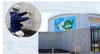
図3：歩道沿い設置された応急給水栓
