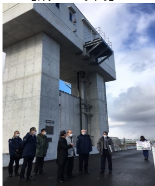
鍋田上水門にて中部地方整備局担当から説明
