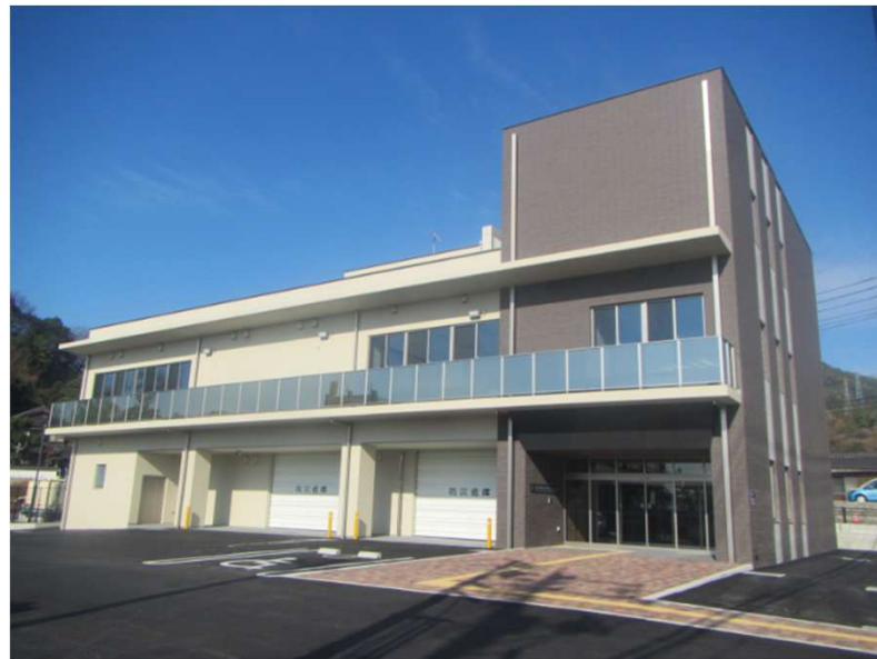
防災庁舎（防災指令拠点施設）
