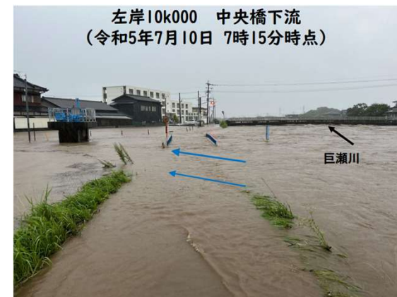
巨瀬川の氾濫状況
