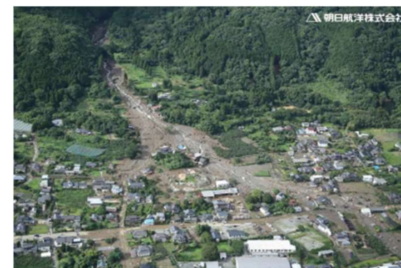
土石流の発生現場（田主丸町竹野）
