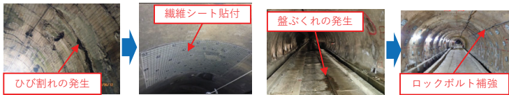
青函トンネルの老朽化対策 (先導導坑の盤ぶくれ対策)
