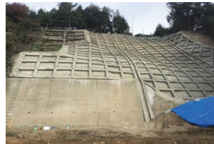
法面防護工による対策 （コンクリート枠による斜面の補強）
