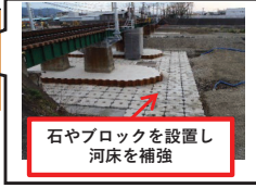
洗掘防止工による対策
