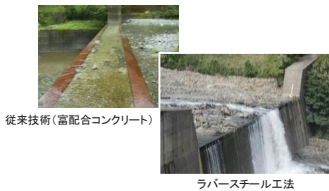
ラバーSteel工法
