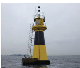
①角石灯標 (工期短縮の取組事例)
