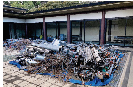
関連工事の発生材(廃棄物等)をまとめて集積・処分
