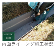
内面ライニング施工状況
