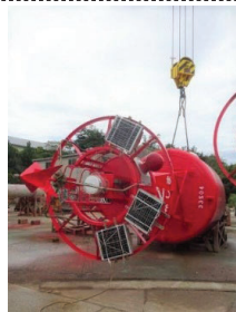
①袖ヶ浦浮標基地 (コスト縮減の取組事例) 定期交換にあわせて 陸上にて監視装置を設置
