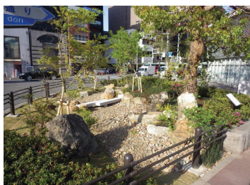
雨水貯留浸透能力を有する雨庭
