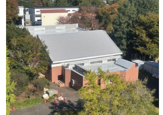
体育館(屋根塗装完成後)
