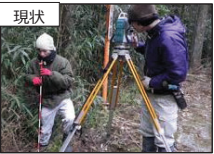
現地に測量機器を設置し、土地の境界点の座標値を測定
