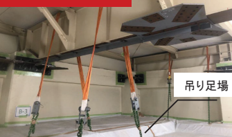
吊り足場設置状況
