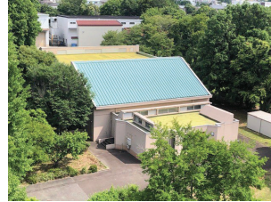
体育館(屋根塗装着事前)
