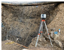
地上型レーザスキャナによる出来形計測
