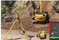
MGバックホウによる掘削(右:バックホウ内のモニター)
