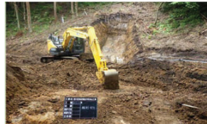
MGバックホウによる掘削
