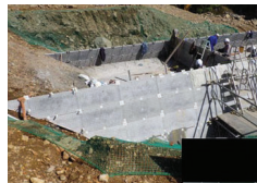
残存型枠を用いた砂防堰堤施工
