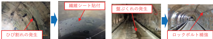
青函トンネルの老朽化対策 (先導坑の盤ぶくれ対策)
