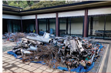
関連工事の発生材(廃棄物等)をまとめて集積・処分
