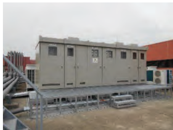
対策後(屋上階)
