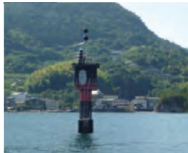
②笠礮灯標 (工期短縮の取組事例) 複数の工種を同時に実施
