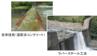
ラバーSteel工法
