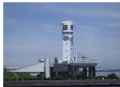
②横浜船舶通航信号所(本牧信号所) 監視カメラを信号所に設置
