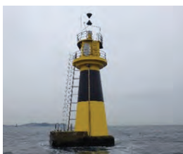
①角石灯標 (工期短縮の取組事例)
