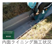
内面ライニング施工状況
