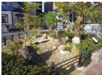
雨水貯留浸透能力を有する雨庭
