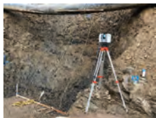
地上型レーザスキャナによる出来形計測
