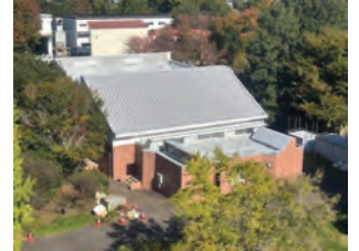
体育館(屋根塗装完成後)
