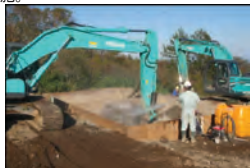
現場発生材を使用した砂防ソイルセメント工法による打設
