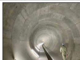
雨水貯留管内部 (仕上がり内径φ5,250mm)
