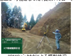
3DMGバックホウによる掘削状況
