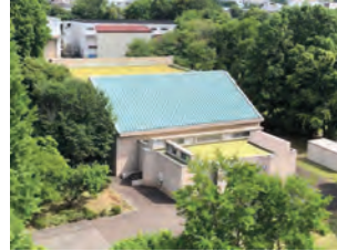
体育館(屋根塗装着事前)
