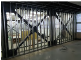
西館 2階教室内壁補強工事
