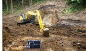
MGバックホウによる掘削
