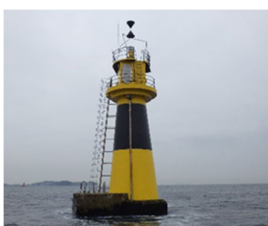
①角石灯標 (工期短縮の取組事例)
