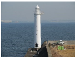
①四日市港防波堤灯台 監視カメラを灯台に設置
