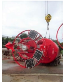
①袖ヶ浦浮標基地(コスト削減の取組事例) 定期交換にあわせて陸上にて監視装置を設置
