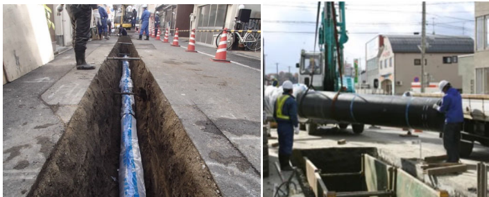
耐震管の布設イメージ
