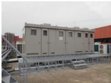
対策後（屋上階）
