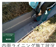
内面ライニング施工状況
