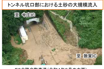
E8北陸自動車道(令和4年8月の大雨)
