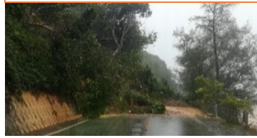
国道505号(令和5年台風6号)
