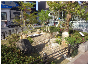
雨水貯留浸透能力を有する雨庭
