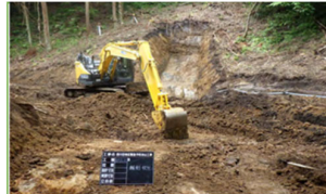
MGバックホウによる掘削
