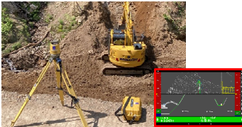
MGバックホウによる掘削(右:バックホウ内のモニター)
