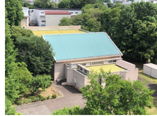
体育館(屋根塗装着手前)
