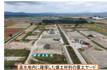
遊水地内に確保した盛土材料の置土ヤード
