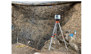
地上型レーザスキャナによる出来形計測
