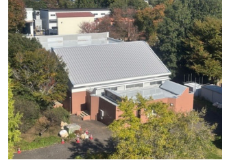
体育館(屋根塗装完成後)
