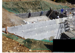
残存型枠を用いた砂防堰堤施工
