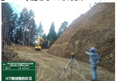
3DIMGバックホウによる掘削状況
