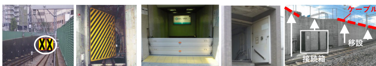
トンネル坑口・トンネル内における浸水対策
