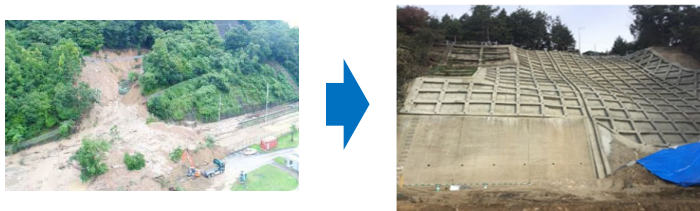
法面防護工による対策 （コンクリート杭による斜面の補強）
