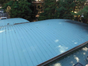
食堂棟カフェテリア上部(塗装工事着手前)
