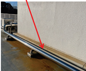
西研修員宿泊棟屋上配管整備状況
