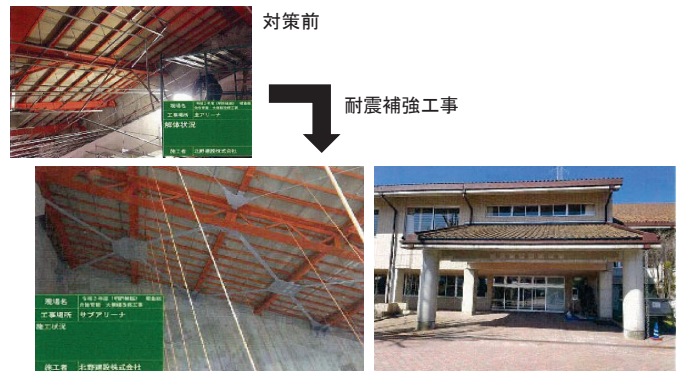
対策前 対策後(屋根のブレース補強: 令和5年3月対策完了)
