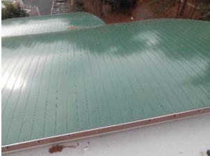
食堂棟カフェテリア上部(塗装工事完成後)
