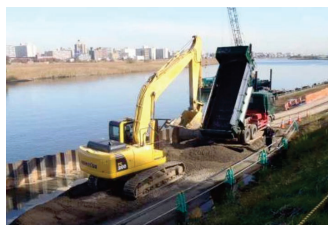
遊水地内に確保した盛土材料の置土ヤード
