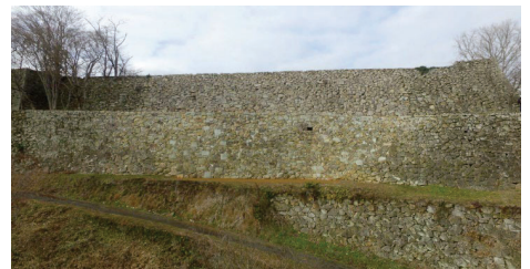
老朽化対策工事完了
