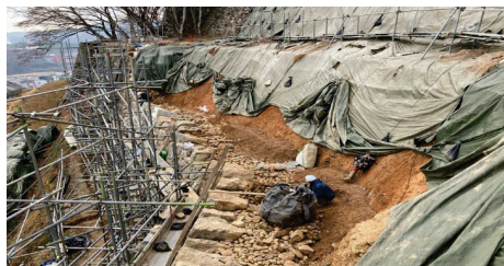
老朽化対策工事
