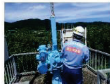
施設毎に機側操作盤により操作
