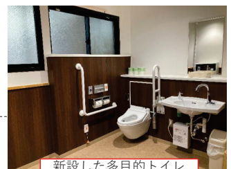
新設した多目的トイレ
