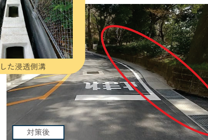
雨水排水用の浸透側溝を新設することで、排水能力が向上し、 令和5年の大雨では浸水被害は発生しなかった（1日当たり190mmの降水量を観測）
