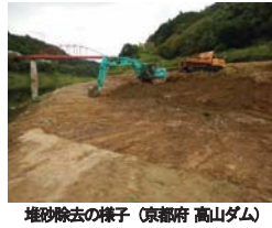
堆砂除去の様子 (京都府 高山ダム)
