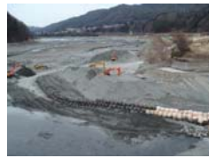
堆砂除去の様子 (長野県 美和ダム)
