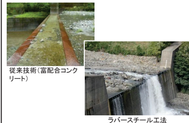
ラバースチール工法
