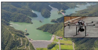
UAVによる湖面巡視
