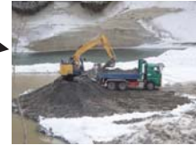
堆砂除去の様子 (宮城県 鳴子ダム)
