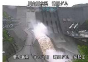
洪水調節実施状況 (鹿児島県 鶴田ダム)
