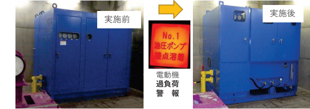
コンジットゲート油圧発生装置更新
