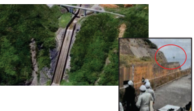
UAVによる劣化調査
