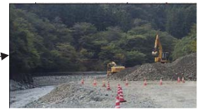
堆砂除去の様子 (北海道 金山ダム)
