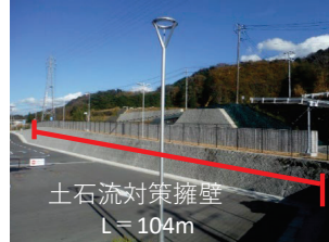
土石流対策擁壁 L=104m
