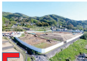
狩野川洪水浸水想定に対応した敷地地盤の嵩上げ状況
