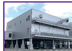
電気設備の地上化
