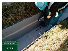
内面ライニング施工状況
