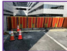
大型止水板の設置
