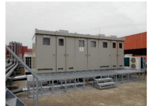
対策後(屋上階)
