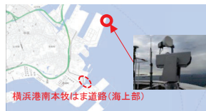
(監視カメラの整備状況)
