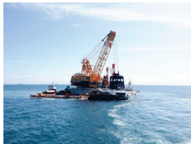
浚渫工事(宇部港)
