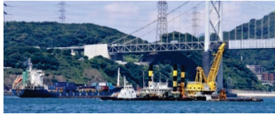
浚渫工事(関門航路)
