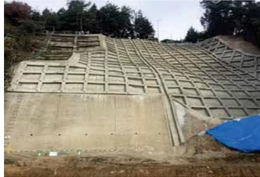
鉄道隣接斜面からの土砂流入防止対策の例
