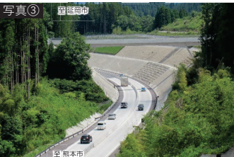
▲写真③ 山都中島西IC～山都通潤橋IC開通後の状況（R6.4）
