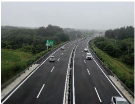
⑤ 三陸北縦貫道路 【令和3年度開通】
