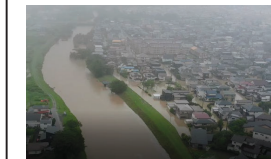
令和5年7月 秋田県秋田市市内の浸水状況 （出典：東北地方整備局HP）
