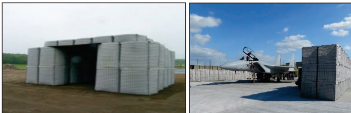
【簡易防護壁(箱型土のう)】
