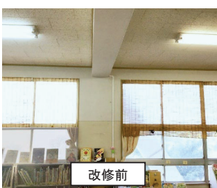
【特別教室空調設備設置事業の事例(神奈川県南足柄市)】
