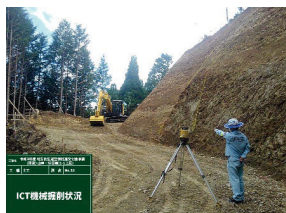
3DGMGバックホウによる掘削状況
