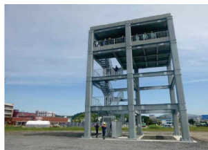
津波避難タワー
