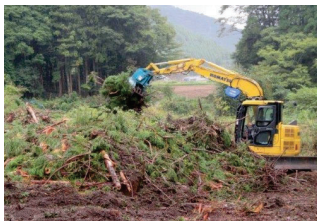
伐採に使用したグラブ を活用した機械地帯え
