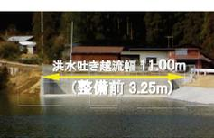
洪水吐き越流幅: 3.25m ⇒ 11.00m
