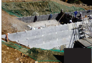
残存型枠を用いた砂防堰堤施工
