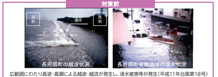
広範囲にわたり高波・高潮による越波・越流が発生し、浸水被害等が発生(平成11年台風第18号)
