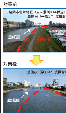
こがせがわ 五ヶ瀬川(宮崎県)の河道掘削時の様子
