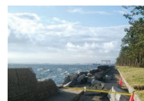
越波による護岸の倒壊
