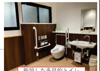
新設した多目的トイレ
