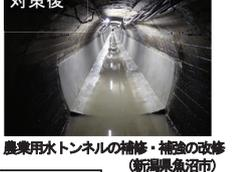
農業用水トンネルの補修・補強の改修(新潟県魚沼市)
