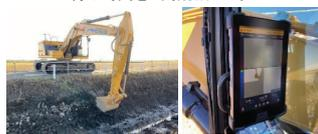
MCバックホウによる施工 MCバックホウモニター画面(掘削位置確認状況)
