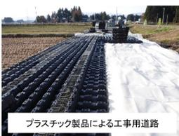
プラスチック製品による工事用道路
