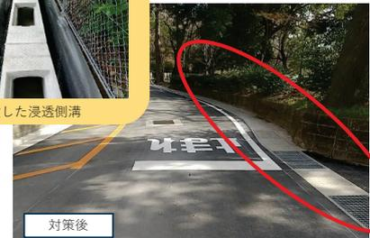
雨水排水用の浸透側溝を新設することで、排水能力が向上し、令和5年の大雨では浸水被害は発生しなかった(1日当たり190mmの降水量を観測)
