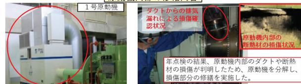
年点検の結果、原動機内部のダクトや断熱材の損傷が判明したため、原動機を分解し、損傷部分の修繕を実施した。
