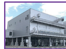
電気設備の地上化
