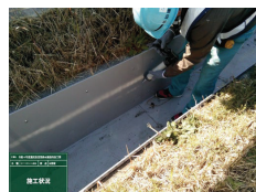
内面ライニング施工状況
