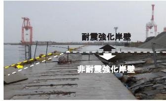
東日本大震災で被災した仙台塩釜港の一般岸壁と耐震強化岸壁
