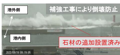
整備後：防波堤の倒壊対策(石材の追加設置)
