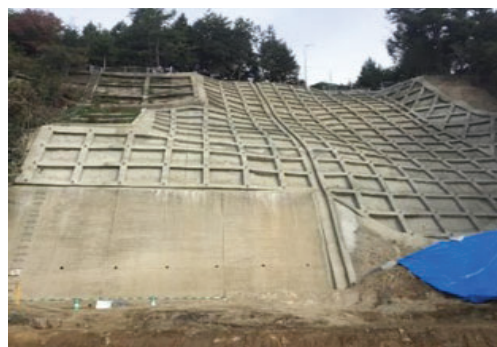
鉄道隣接斜面からの土砂流入防止対策の例 （コンクリート枠による斜面の補強）
