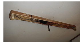
廃墟にて発見されたPCB使用安定器
