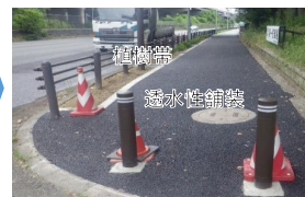
【対策後】 雨水貯留浸透機能の確保
