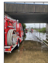
消防団による消防ポンプ自動車を活用した排水作業の様子（千葉県九十九里町提供）
