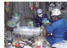
処理施設における補修作業
