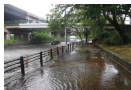
【対策前】 令和3年5月冠水
