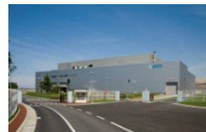
JESCO(高濃度PCB廃棄物処理施設)
