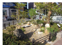
雨水貯留浸透能力を有する雨庭
