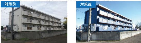
＜鉄筋コンクリート造の壁にスリット施行を施した耐震補強＞
