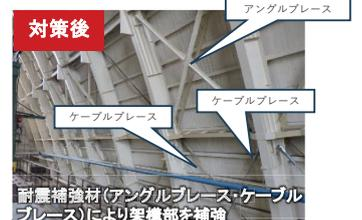
架構部の耐力不足等により、地震の振動および衝撃に対して倒壊又は崩壊する危険性が高い状況と診断されていた。
