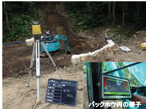
MGバックホウによる掘削
