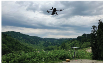
UAVによる起工測量
