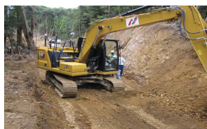
ICT建機による法面掘削
