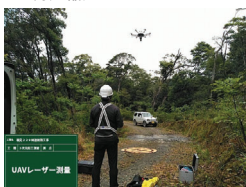
UAVレーザ測量
