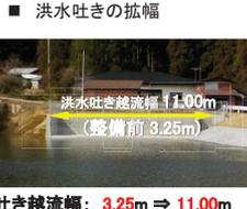
洪水吐き越流幅: 3.25m ⇒ 11.00m
