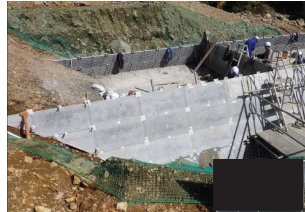
残存型枠を用いた砂防堰堤施工
